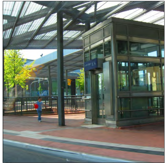
Das Solingen eine Industriestadt ist, in der das Pragmatische ausnahmslos über das konzeptionell-Phantasievolle siegt, verrät sich sogar in Profanbauten wie Haltestellen.
