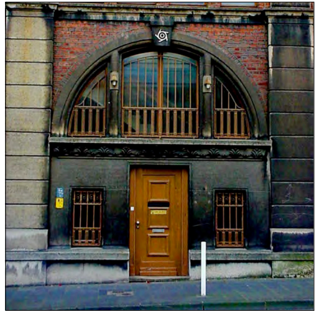
Industrie-Architektur, das klingt nach „Zweckbauten“. Einerseits stimmt es, andererseits hat man aber immer schon Fabriken auch ein wenig liebevoll im Detail gestaltet.
